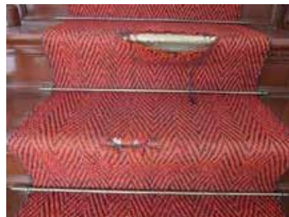
Foto 5: Durchgescheuerte Stufe
