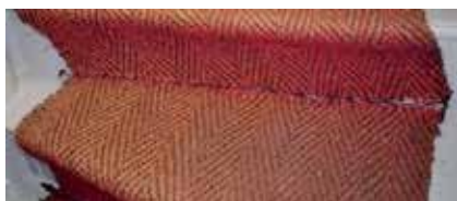
Fotos 6 + 7: Fehlerhafte Verlegung
