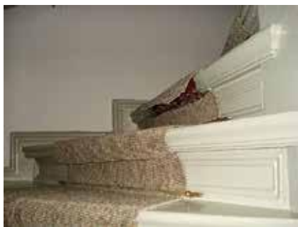
Fotos 6 + 7: Fehlerhafte Verlegung
