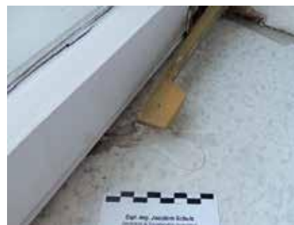
Foto 3: Eintretendes Niederschlagswasser
